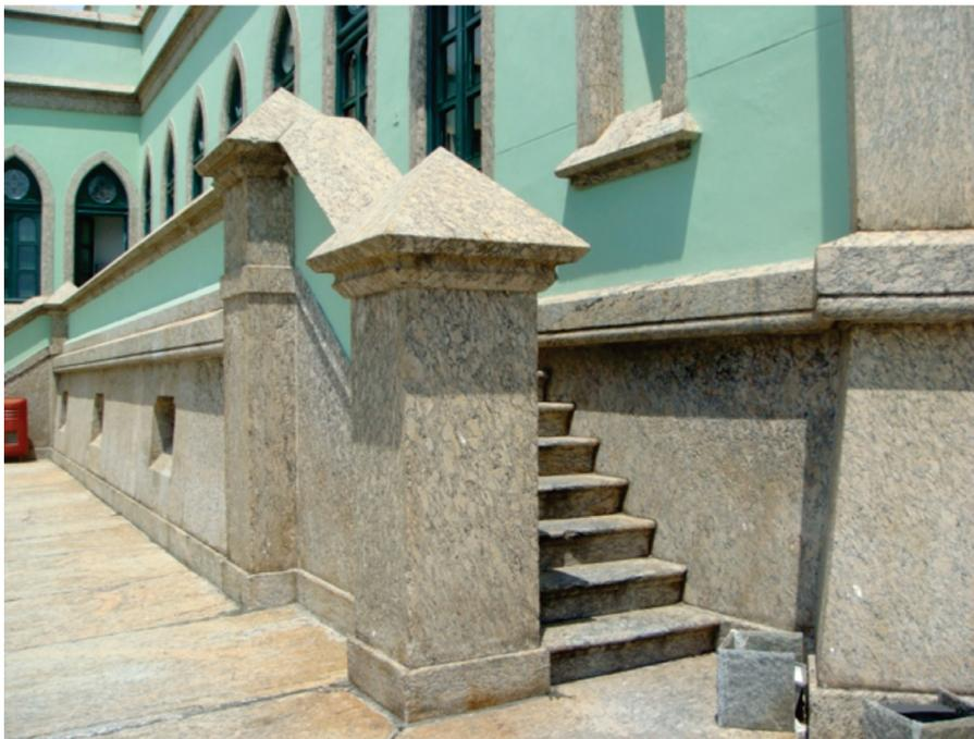
**Figura 17.** Muros exteriores autoportantes sobre cimientos de piedra.
