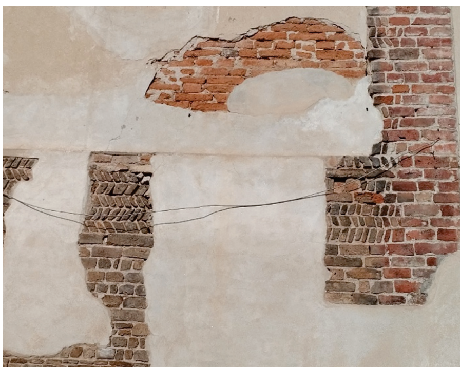
Figura 2. Estratigrafía mural del paramento exterior de la rectoría de la Basílica (2024). [Archivo de la autora, 2025].
