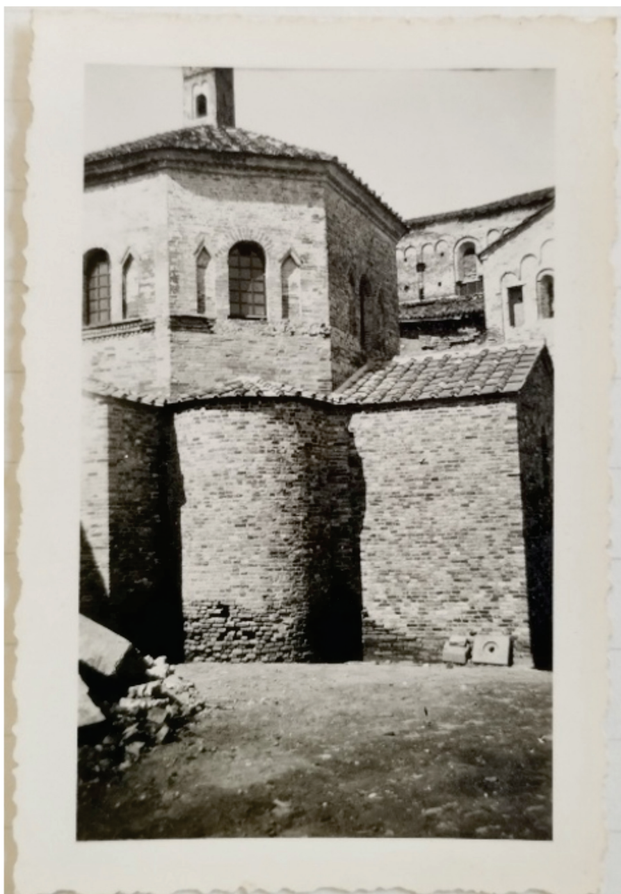
Figura 7. Lomello. Baptisterio de la Basílica de Santa María la Mayor. Demolición de edificios adyacentes al Baptisterio. Proyecto de Gino Chierici (1939-1945). [Archivo Magenta, Lomello].
