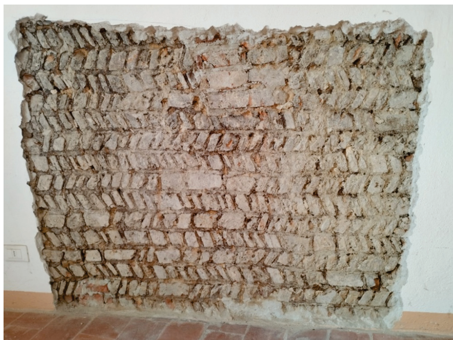
Figura 3. Rectoría de la Basílica. Un muro antiguo con un patrón de mampostería en “espina de pescado” típico de la arquitectura medieval tardía (siglo XI). [Archivo de la autora, 2025].
