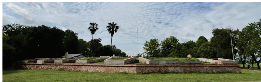
Figura 2. Muros vistos desde el NO mostrando la fachada exterior inclinada, una cornisa o pequeño remate con ladrillos dispuestos de canto (verticales) y con extremidades redondeadas (ubicado ~ 1,60-1,70 m por encima del nivel actual del terreno), ocho troneras y, entre ellas, los merlones.
