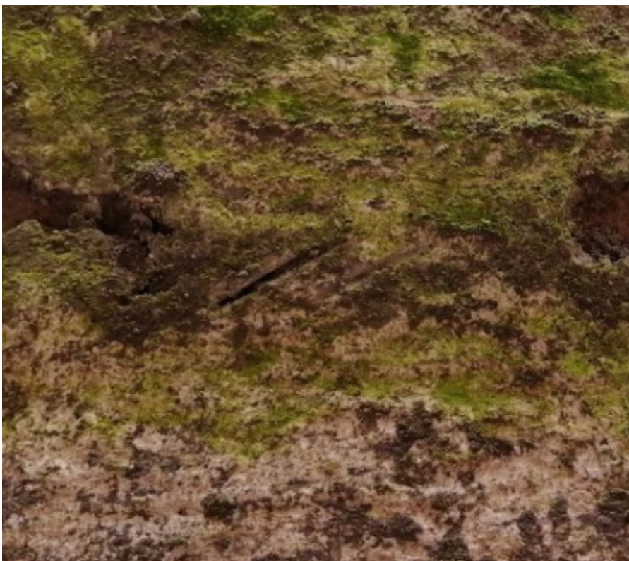
Figura 9. Detalle de líquenes en el revestimiento de barro.
