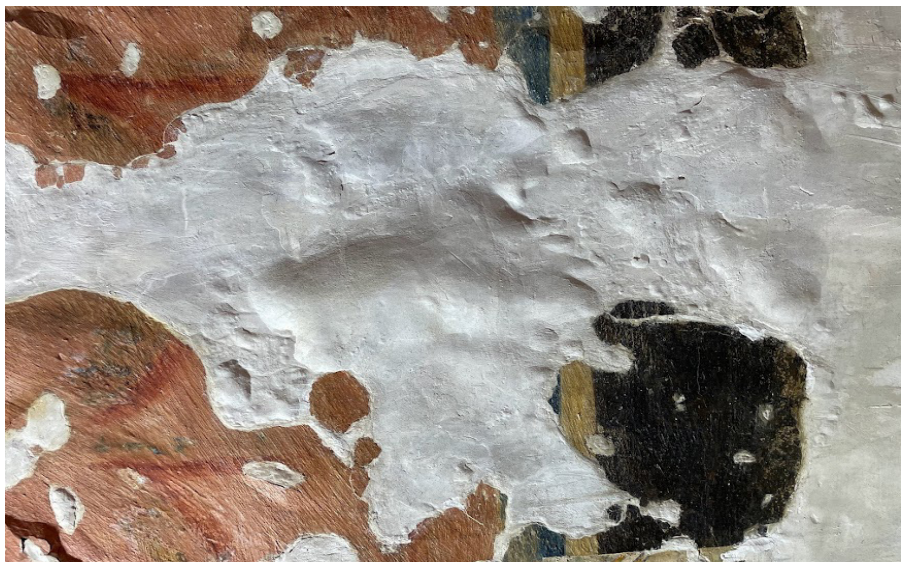
Figura 12. Abolsamientos y descohesión de estratos.
